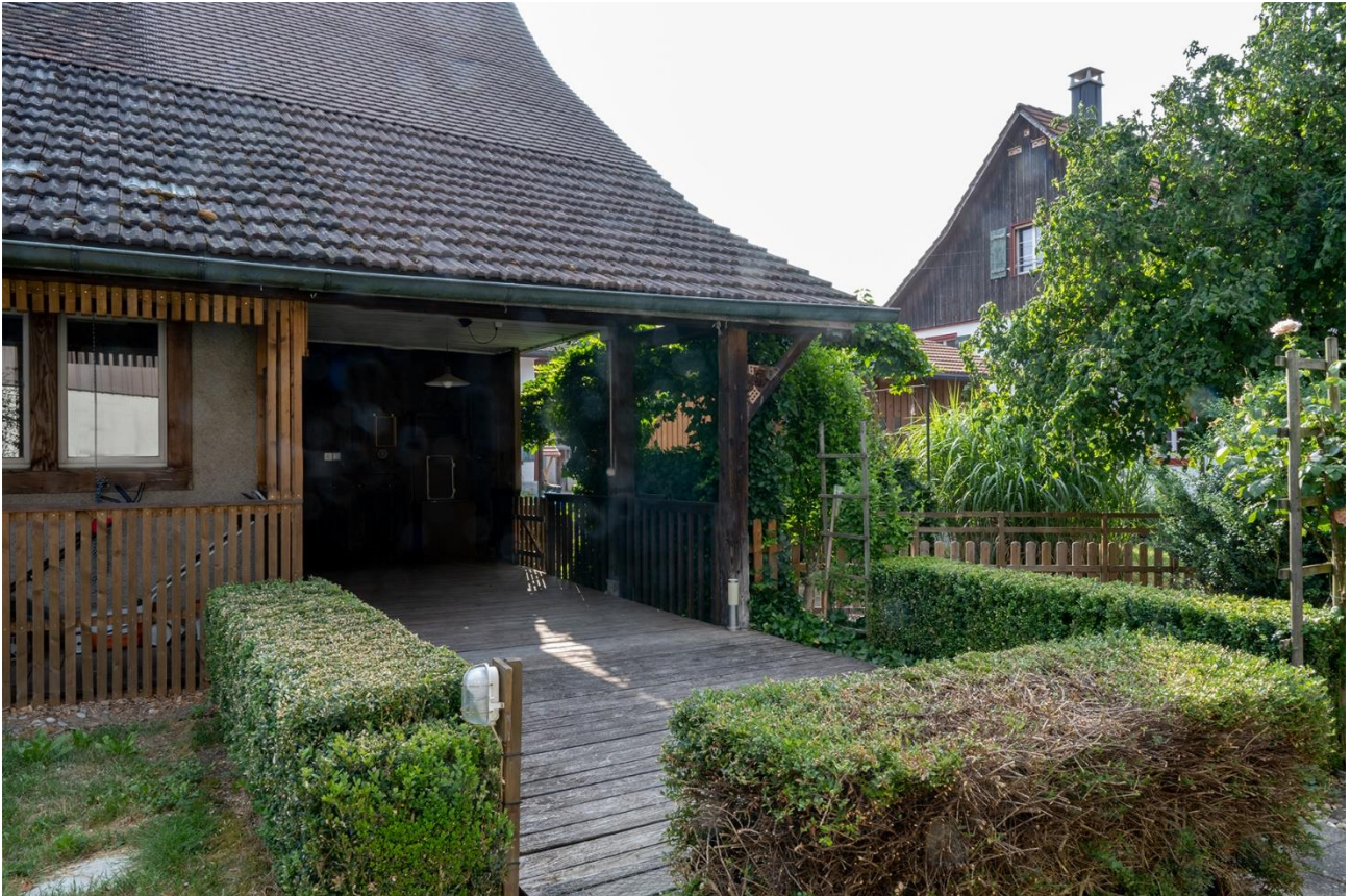
Sitzplatz Westseite Scheune
